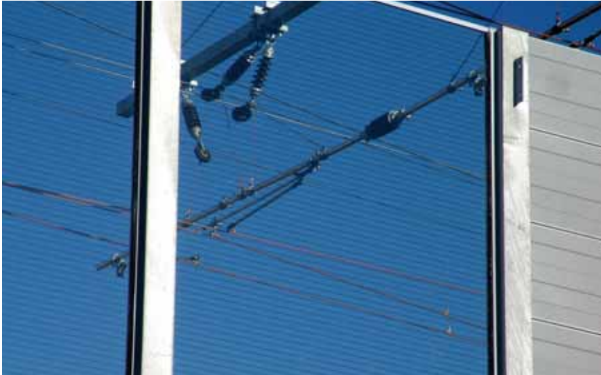
Wirksamer Schutz gegen Vogelschlag kann recht unauffällig sein: Schmale schwarze Streifen schützen wirksam in heller Umgebung.
