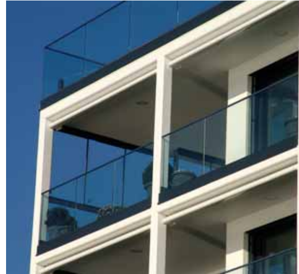
Schlimmer geht's kaum: Glasflächen übers Eck und auf dem Dach sind tödliche Fallen für Vögel.
